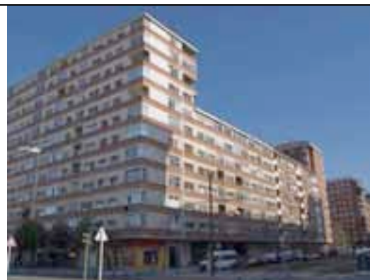
Juntas Generales, 1 y Portal de Foronda, 36
