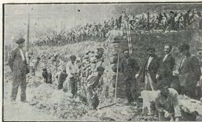
Llodio.—Abriendo zanjas para el tendido de la cañería
