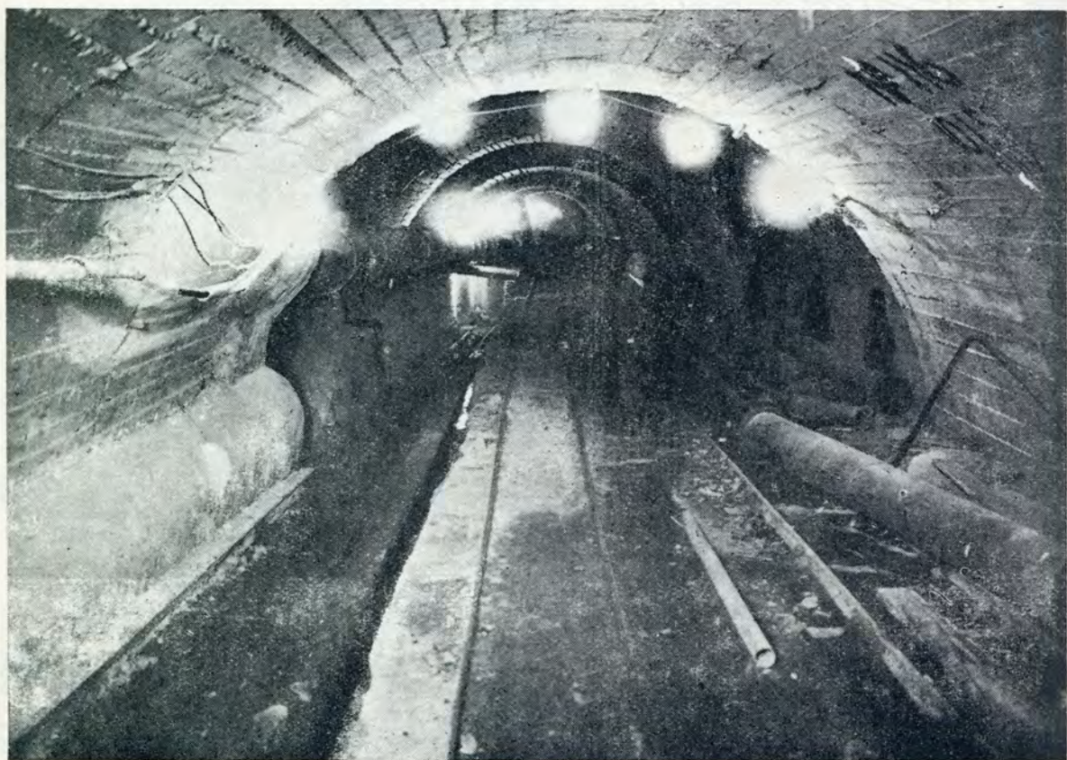
Galería de acceso a la central de Undunaga. Revestimiento de la media sección superior.
